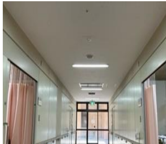
防カビ処理と上塗り塗装を実施
